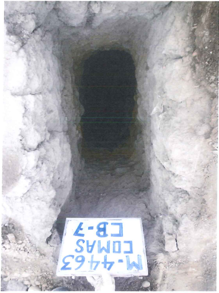
UBICACIÓN DE LA CALICATA CB-7.
